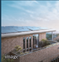
太陽光発電システム
