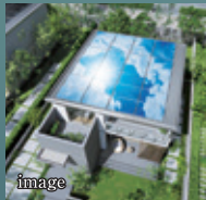
太陽光発電 システム
