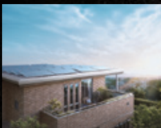
エネルギーを創る 〈太陽光発電システム〉
