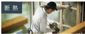
工場で断熱材を適切な形でしっかり充填
