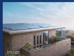
太陽光発電システム
